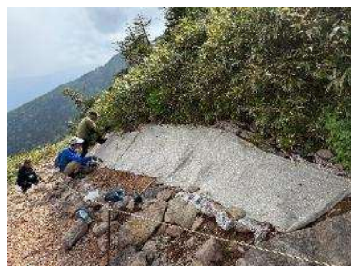
BSCシート敷設作業
