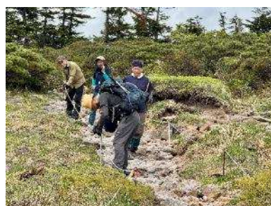
ロープ設置作業
