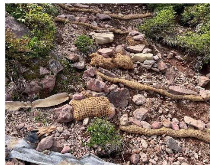
西大巔崩壊地帯
