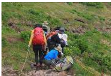
ロープ設置作業
