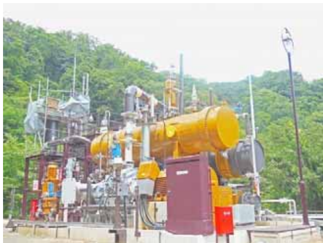
土湯温泉のバイナリー発電機(左)と西山温泉の地熱発電所(右) 発電機と発電所の違い、規模が全く違うことが分かる
