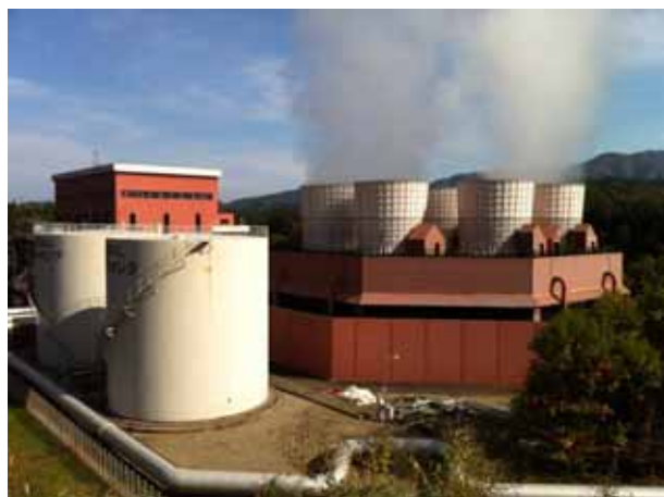
土湯温泉のバイナリー発電機(左)と西山温泉の地熱発電所(右) 発電機と発電所の違い、規模が全く違うことが分かる
