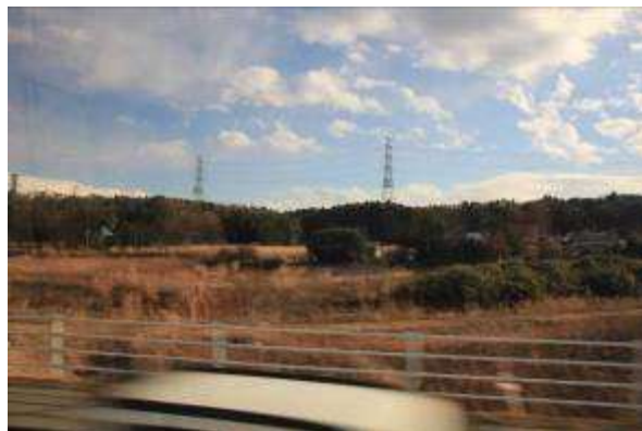
葎に覆われた常磐線と空の送電線
