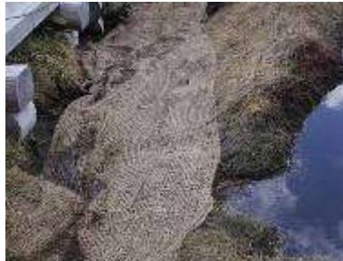
植生回復ネットの敷設処理 (2007年6月3日)
