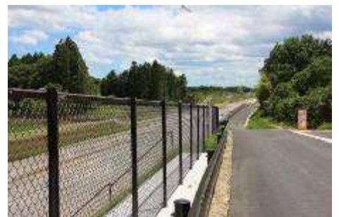
常磐道の工事が進んでいる
