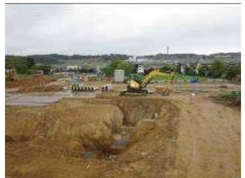
宅地の造成が進む町の様子
