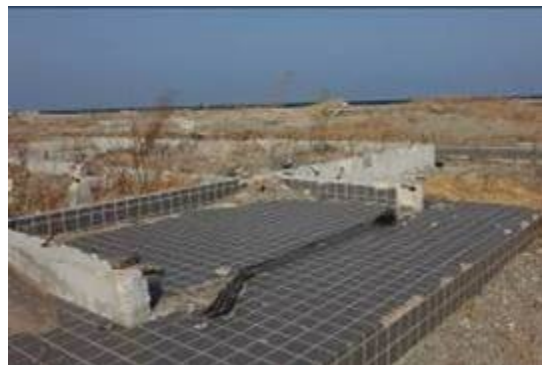
基礎のみ残る家
