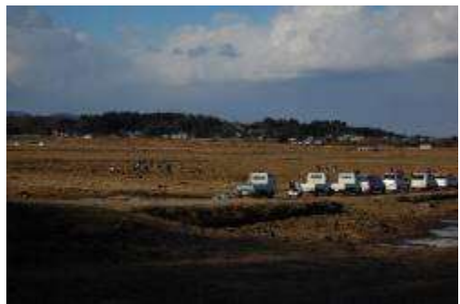
水田に埋もれたガレキの撤去作業 (作業は被災集落総出で)
