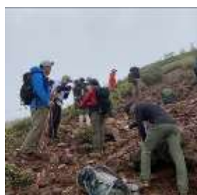
ロープ設置作業
