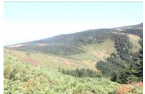
西大巓からの登山道崩壊状況
