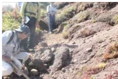
西大巓山頂直下の斜面崩壊
