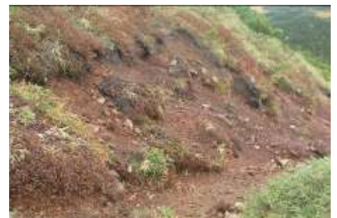
崩壊は進行中
