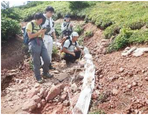
根巻シート施工を点検
